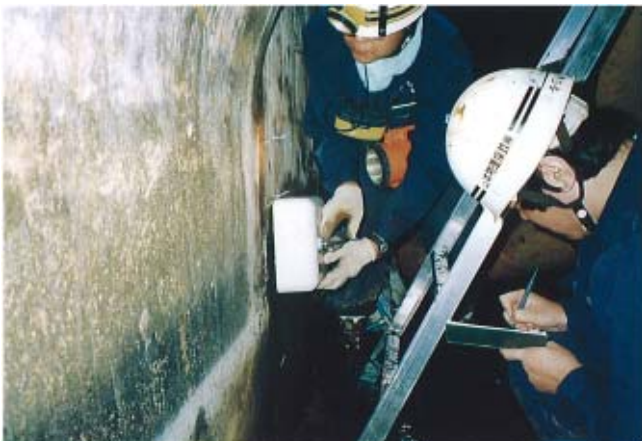
鉄筋スコープを用いた測定状況
