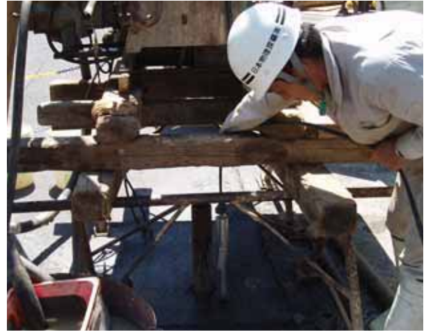
孔内用微動計設置作業
