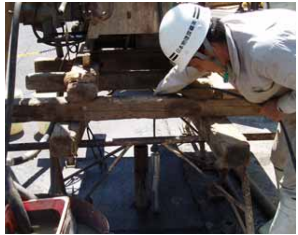
孔内用微動計設置作業
