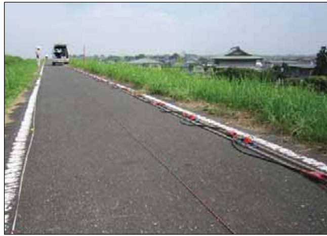
← 表面波探査測定状況
