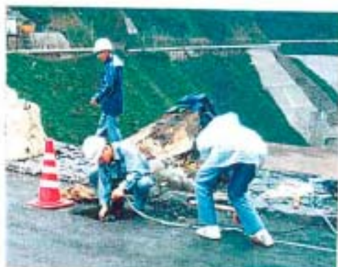
孔内常時微動計の設置
