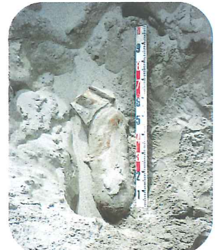
磁気データによる掘削確認(100ポンド爆弾)
