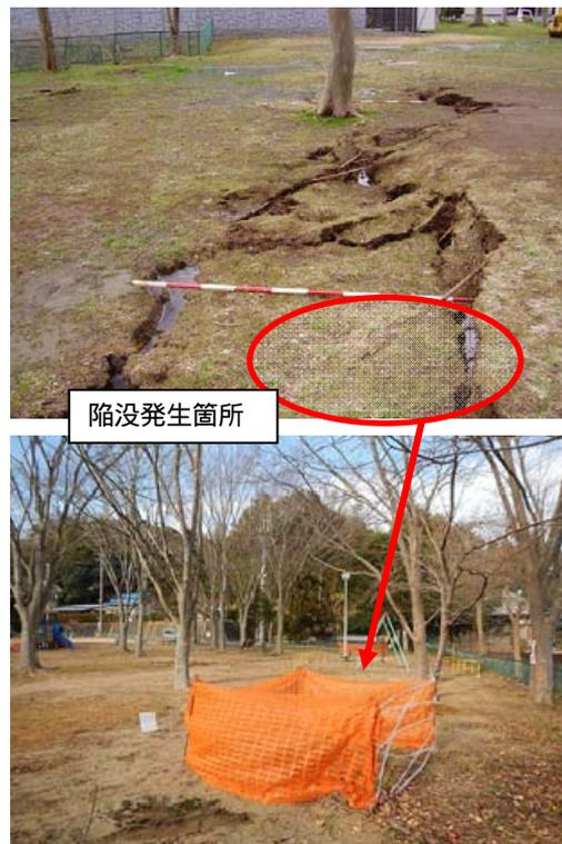
図 4.1 東側陥没穴付近に広がる南北の亀裂（液状化跡）
