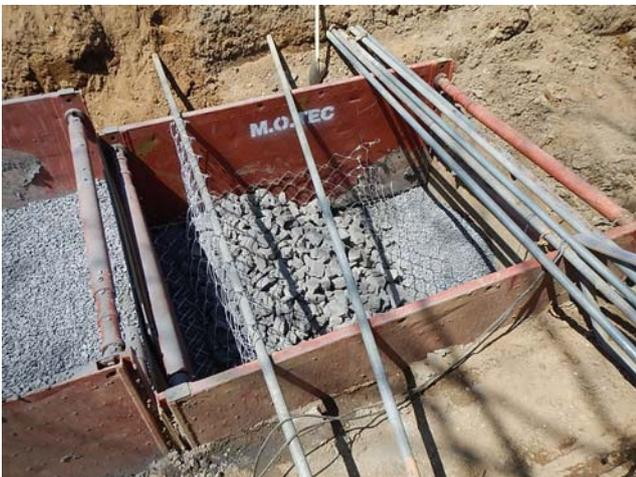
図4.6 トレンチシステムにより施工中の5号珪砂と玉石
