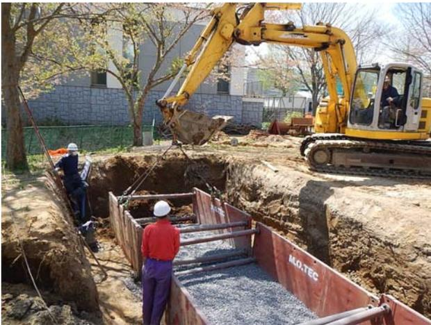
図 4.5 施工中の人工砂礫層となる玉石層の上部に5号珪砂(トレンチシステム引き抜き)
