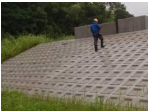
図7-1 欠陥を模擬した堤防の張りブロック
