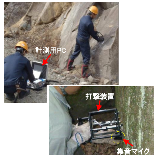
図 6-5 岩盤斜面での測定状況
