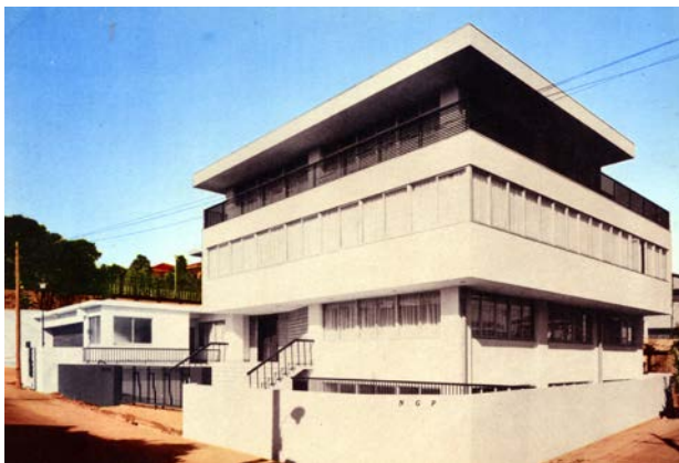
写真8 1967（昭和42）年に大田区中馬込に新築された日本物理探査本社社屋
