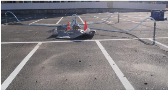
写真 4 土壌内空気吸引状況
