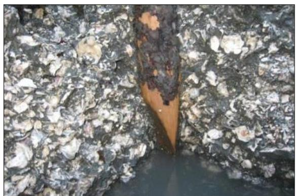
写真-4 牡蠣層に打設された松杭 (B,C,D,E 列杭)
