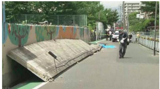
写真 1. 小学校ブロック塀の倒壊事例
