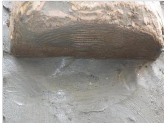
写真-2 A と E 列の杉杭 (樹皮なしで下端が水平)
